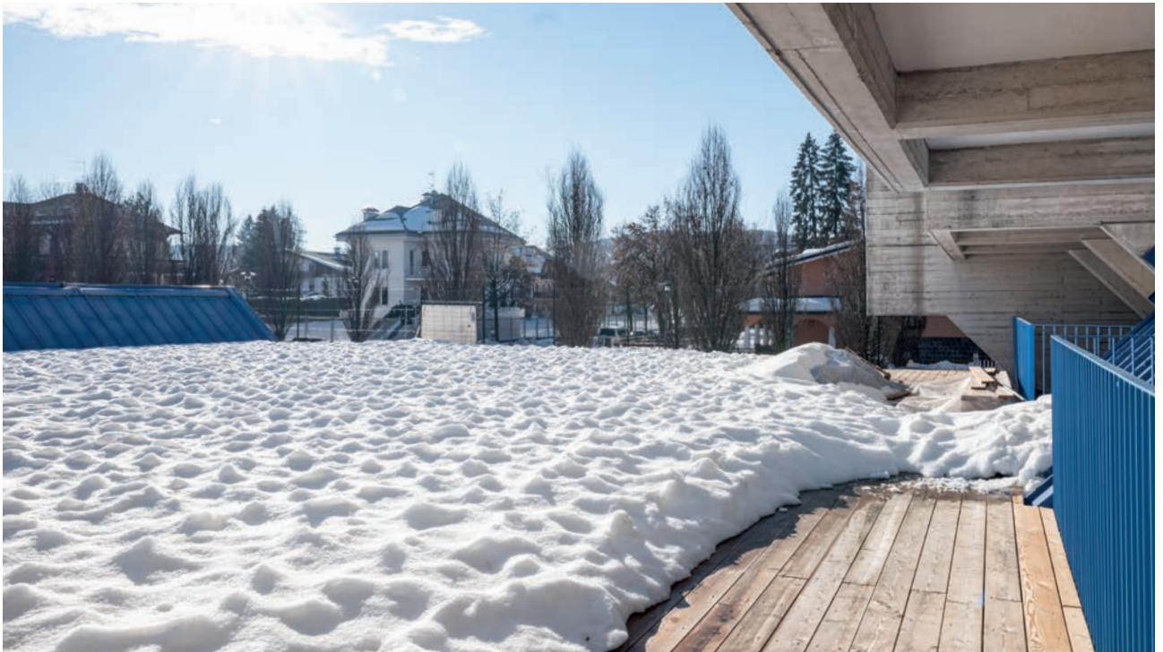
Istituto Comprensivo Statale – Rooftop, terrasses Asiago (VI), Italia Woodeck System – New Maxi NM
